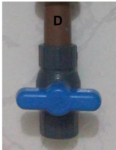
Figura 3.16- Braço do registro de expurgo.
