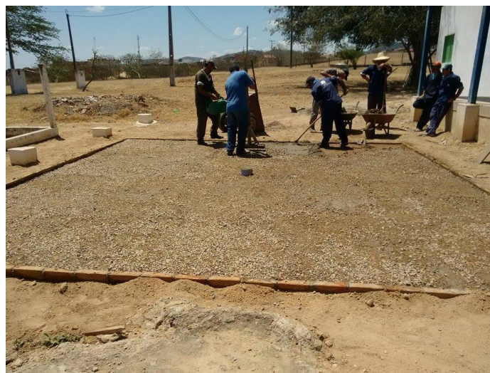
Figura 4.4: Preparação e nivelamento do solo. Foto do autor.
