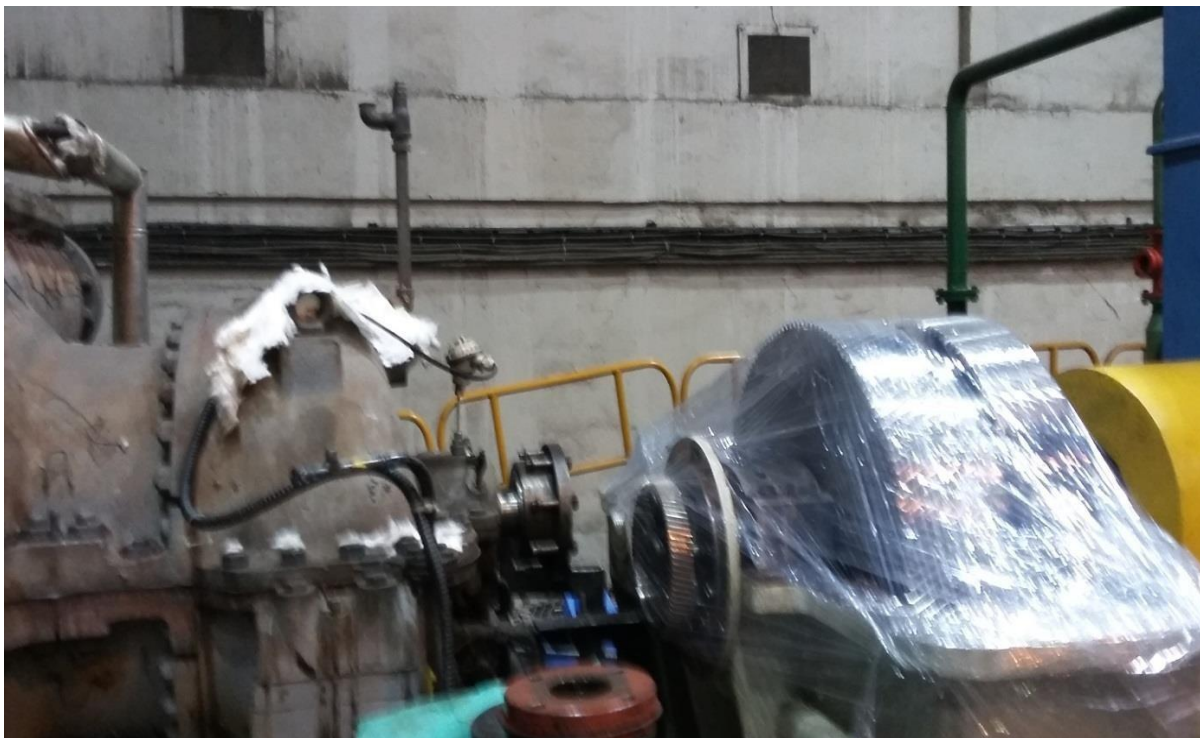
Fig. 26: tubo gerador em manutenção
