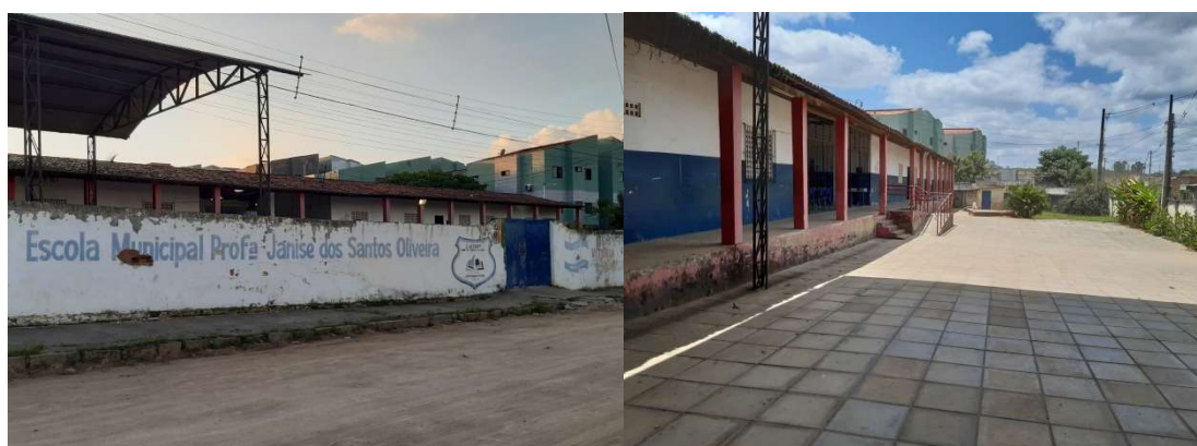
Foto 01 – Fachada da Escola.
