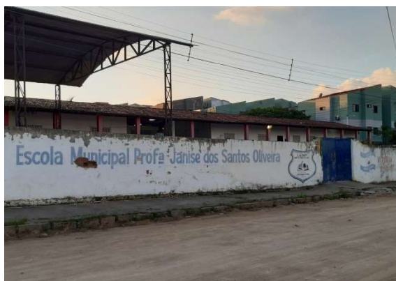
Foto 01 – Fachada da Escola.
