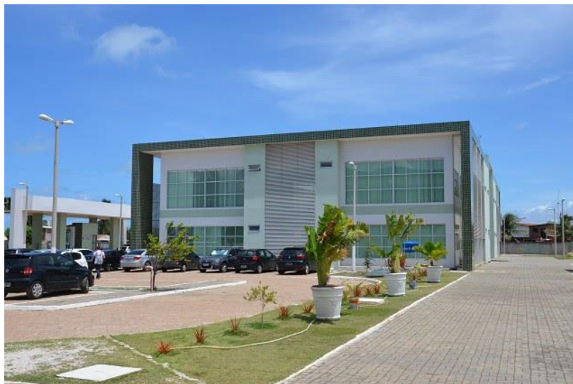
Figura 4.1 – Prédio da administração
